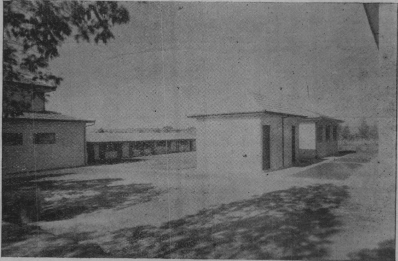
Vista do biotério, casa do gásômetro e almoxarifado.
