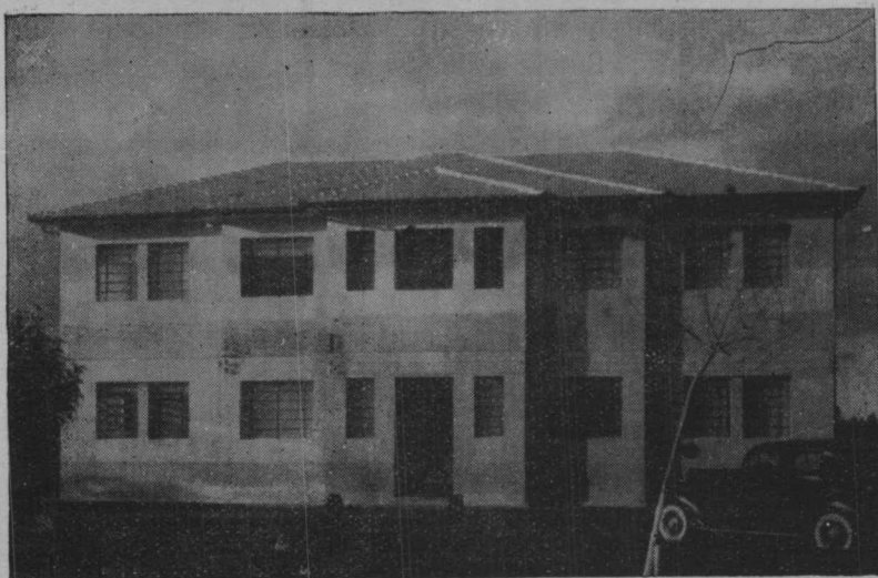
Vista Geral do prédio do Instituto
